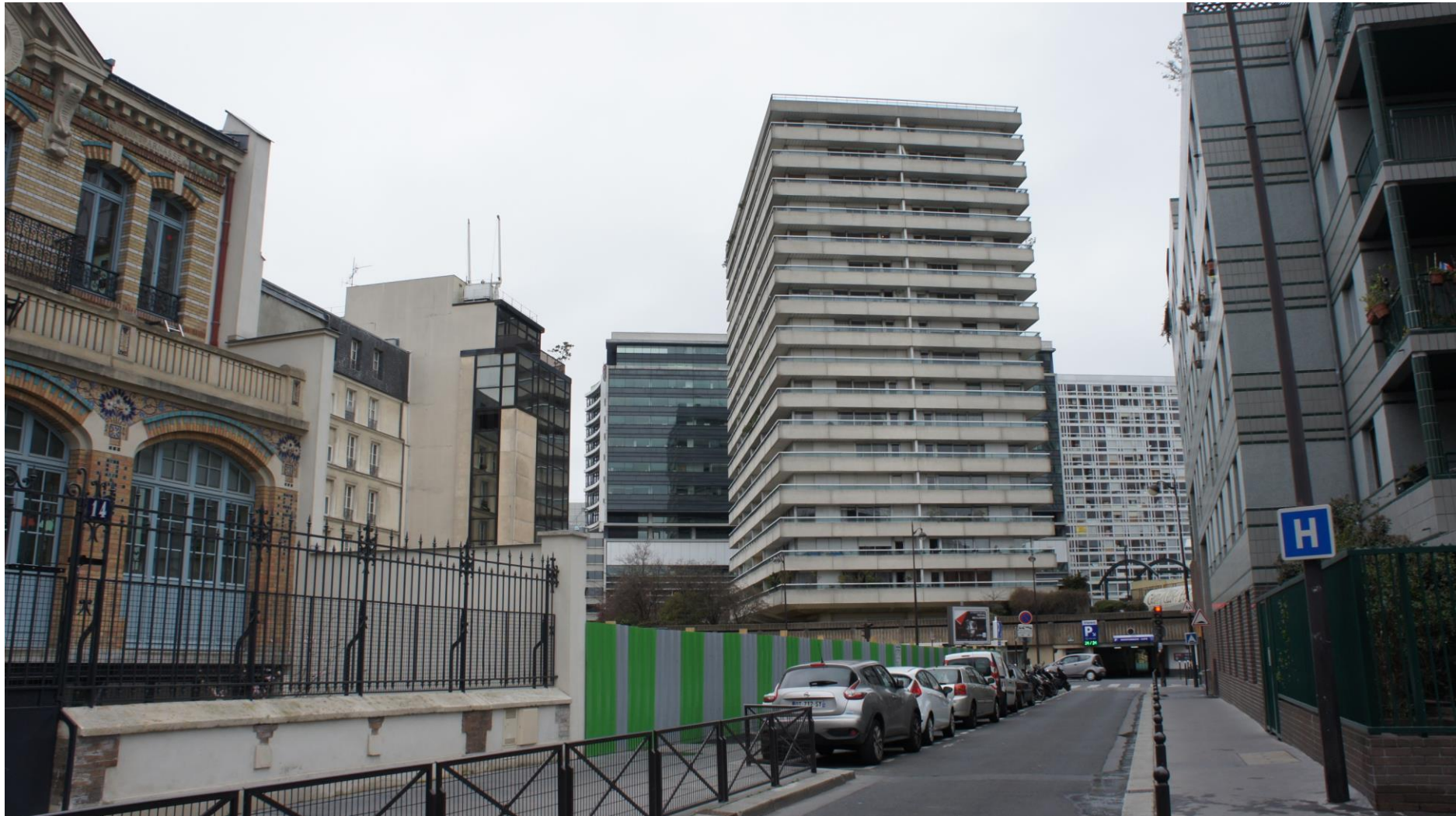
Photo n°51 (Crèche) - Rue Jules Guesde (vue depuis le Sud-Est)
