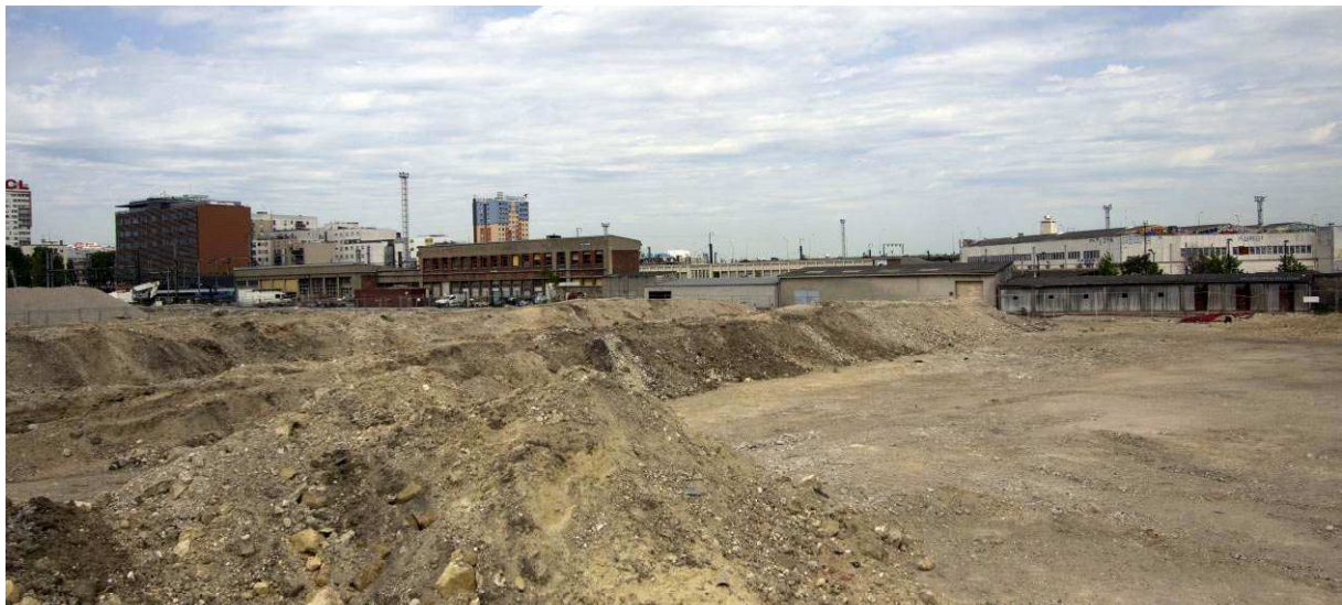
2. Vue depuis le site vers le nord-est (tour de la Porte des Poissonniers) – mai 2015
