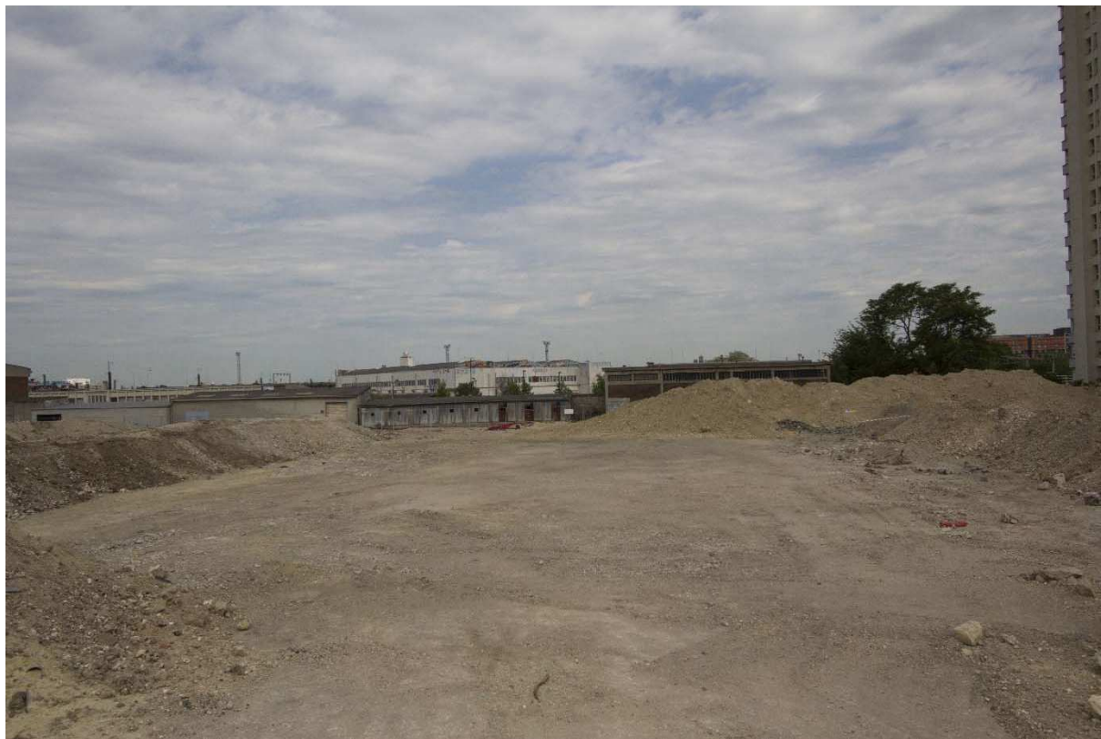
1. Vue depuis le sud du lot C vers le nord – mai 2015
