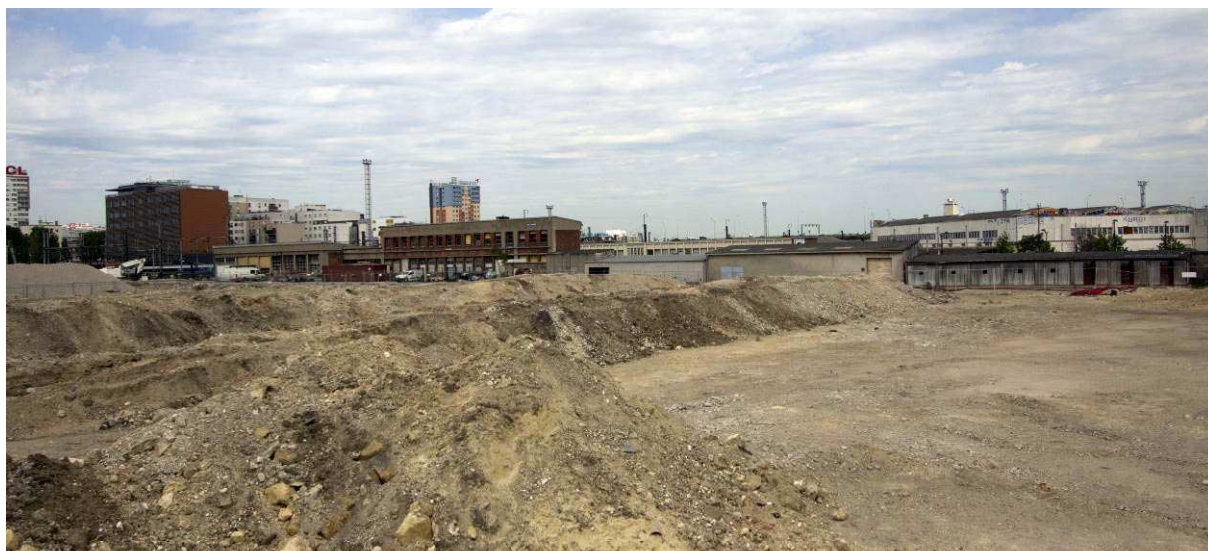
2. Vue depuis le site vers le nord-est (tour de la Porte des Poissonniers) – mai 2015
