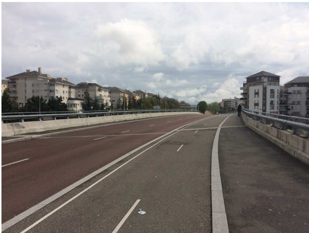
Photographie 15 : Vue de l'infrastructure du TCSP TVM – viaduc de franchissement de la Ligne 8
