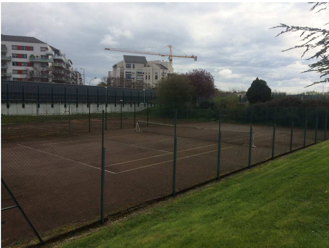
Photographie 8 : Vue des cours de tennis non entretenus (1)
