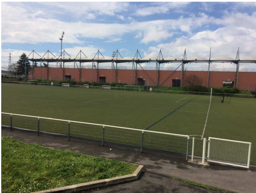
Photographie 13 : Vue des structures associées au stade Duvauchelle (2)
