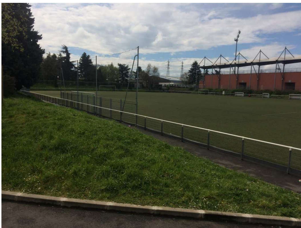
Photographie 12 : Vue des structures associées au stade Duvauchelle (1)
