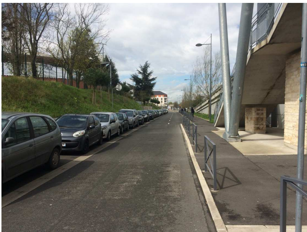
Photographie 14 : Vue de la rue de desserte du parking, en prolongement de la Route de Pompadour
