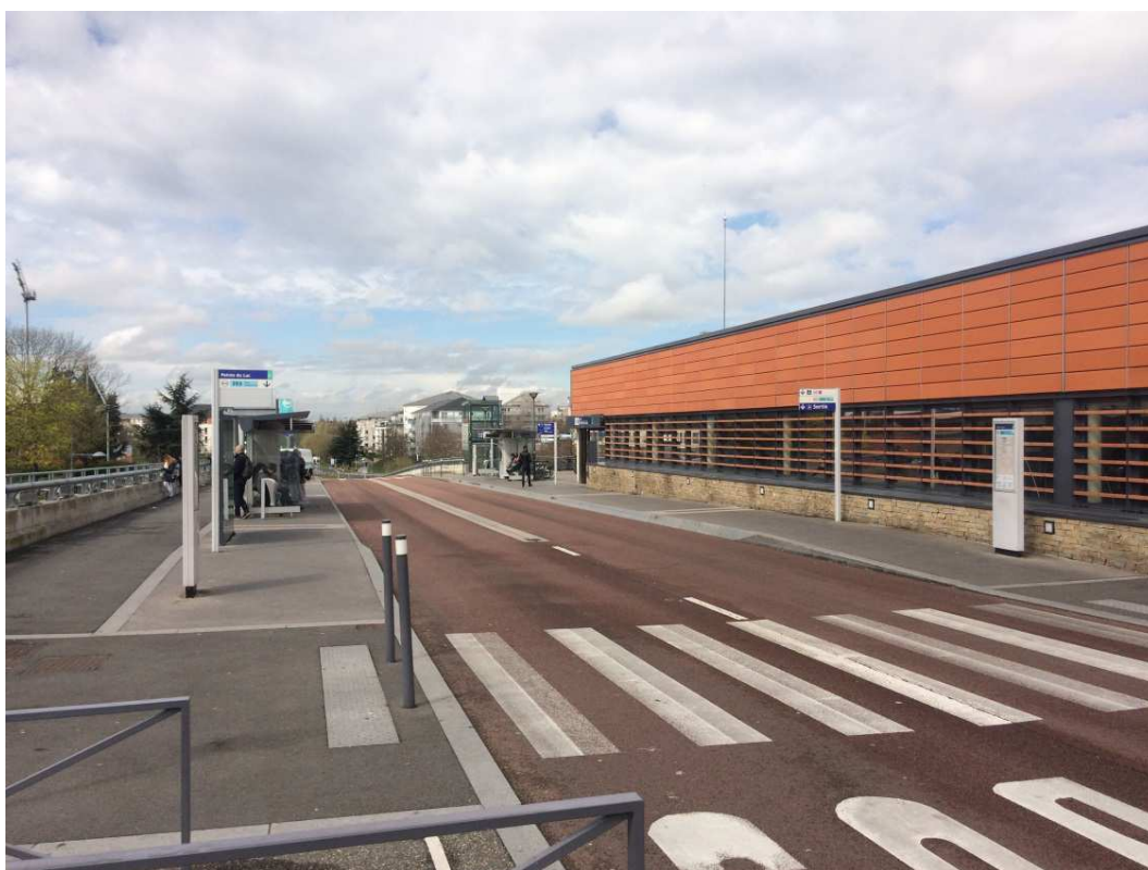
Photographie 16 : Vue de l'infrastructure du TCSP TVM – viaduc de franchissement de la Ligne 8 et de la gare de Créteil – Pointe du Lac
