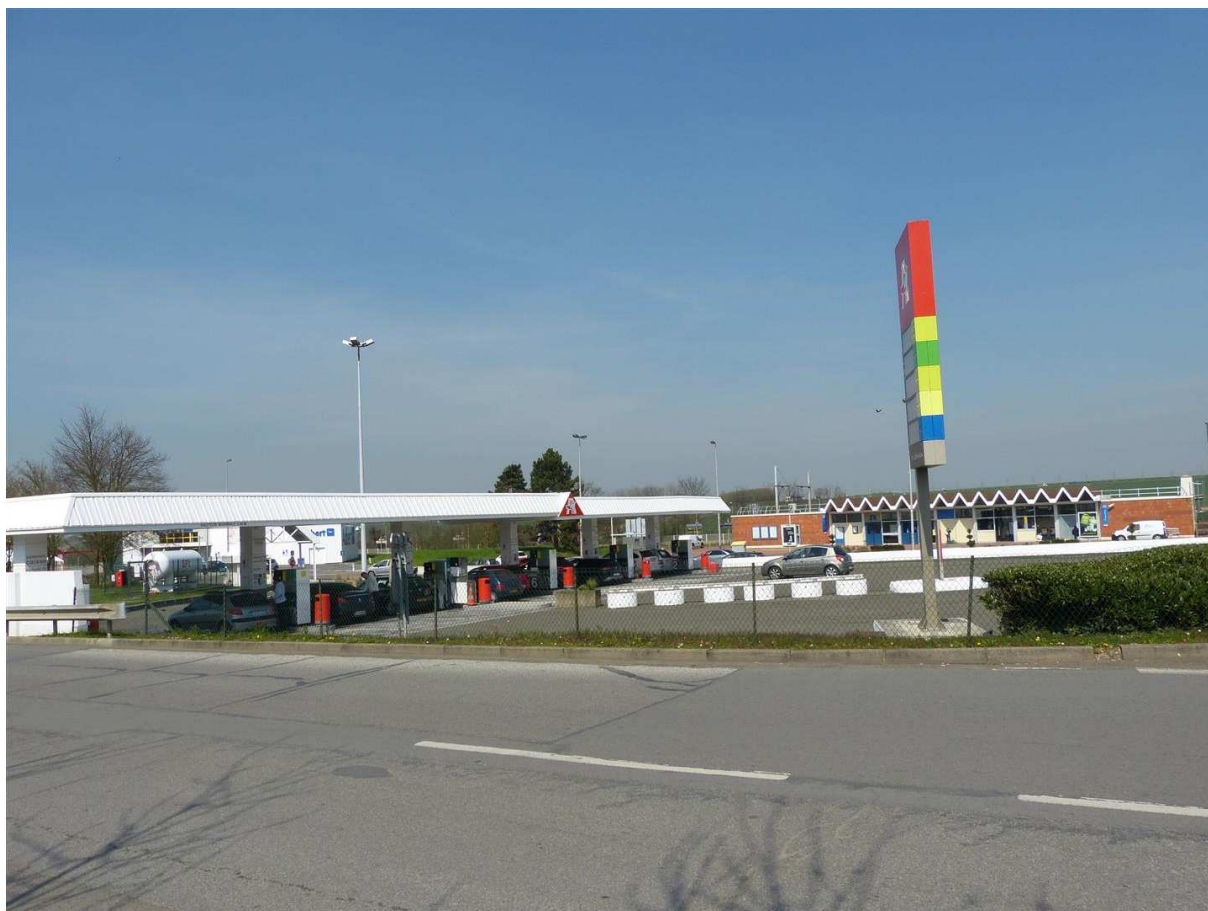
P3 : prise de vue numéro 3. Cette photographie permet d'illustrer l'emplacement de l'actuelle station-service sur laquelle aura lieu l'extension de commerces et des parkings sur 2 niveaux.
