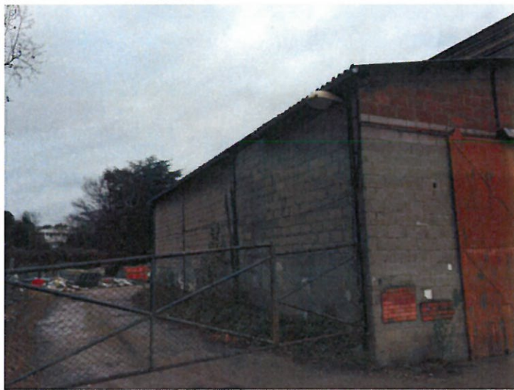
Photos des bâtiments désaffectés du site
