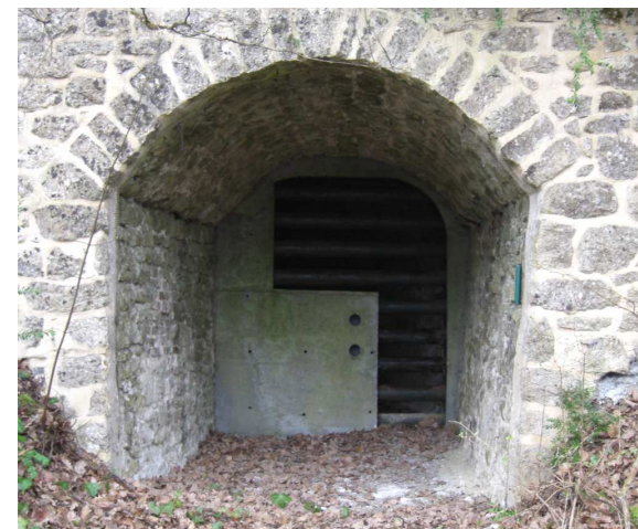
Grille à barreaux horizontaux de l'entrée 2 ©M. Larroque – Mars 2009
