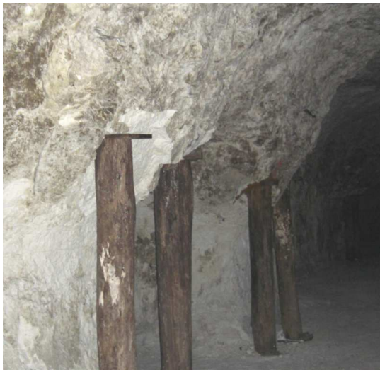
Exemple de soutènements avec des piliers en robinier ©M. Larroque – Mars 2009
