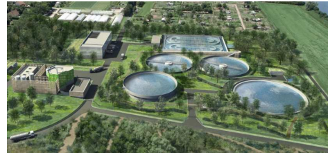
Station d'épuration de Rosny-sur-Seine
