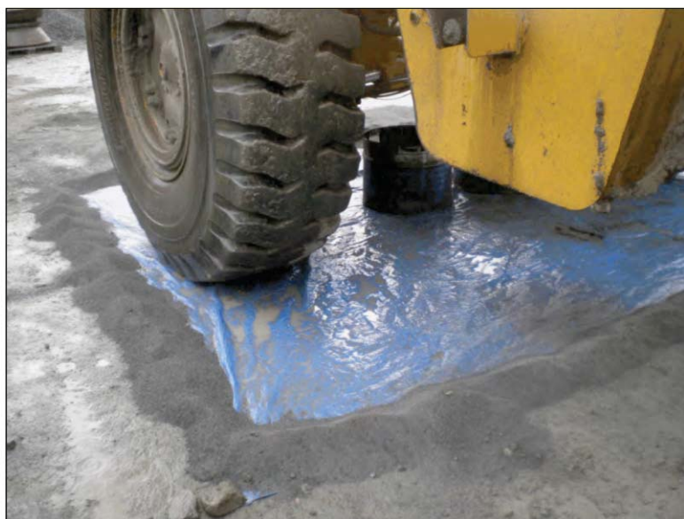
Exemple d'aire étanche mobile
