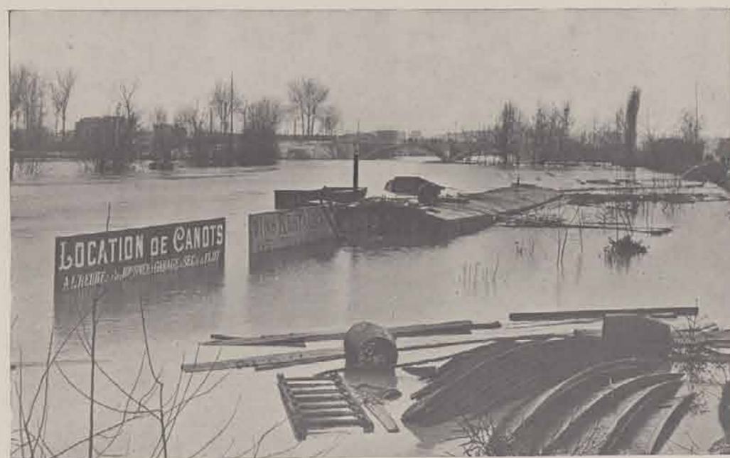
BILLANCOURT : Garage à sec.
