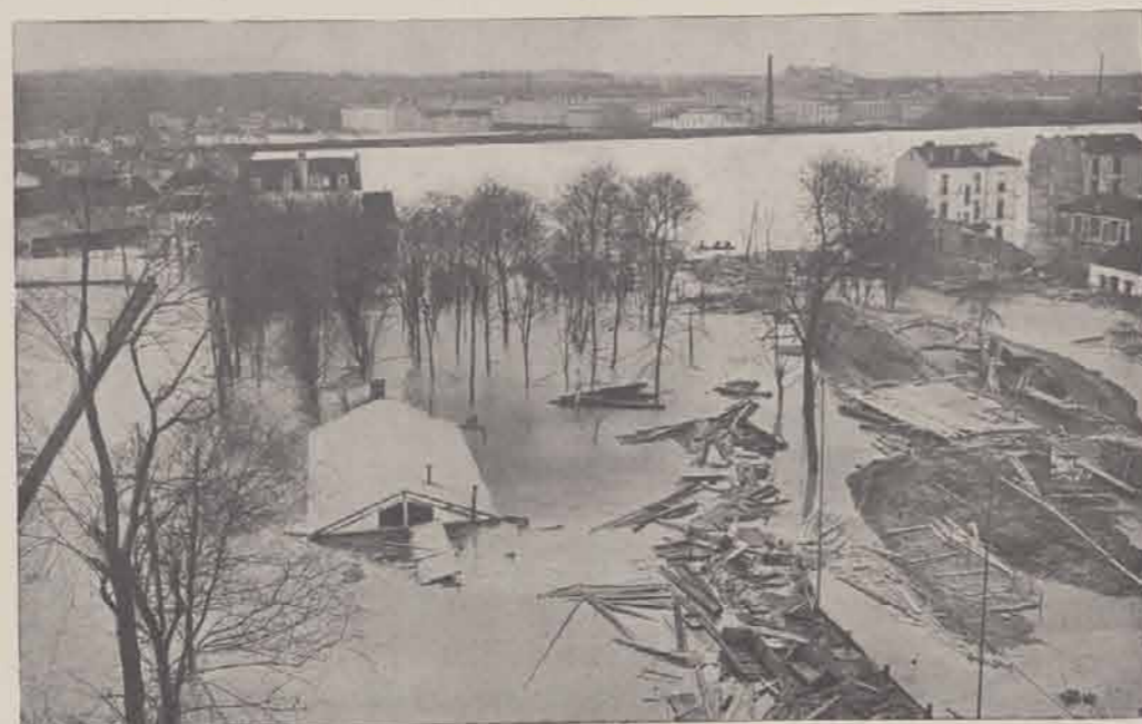
COLOMBES : Rupture de la Digue.
