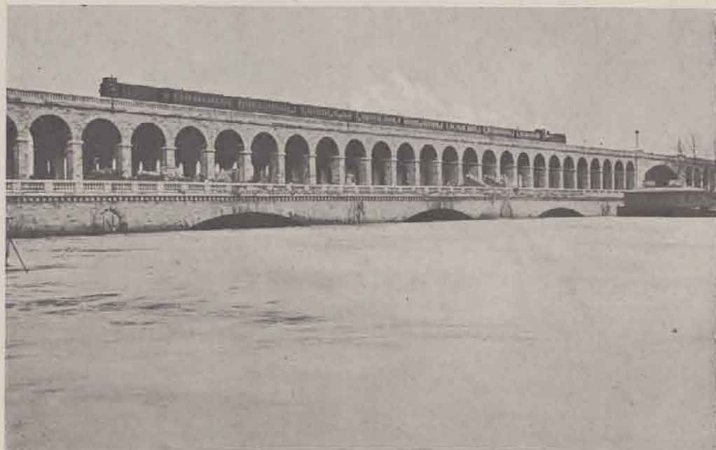
Le viaduc d'Auteuil.
