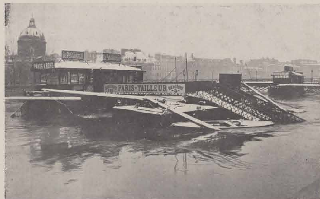
Quai du Louvre. — Station du pont des Arts.
