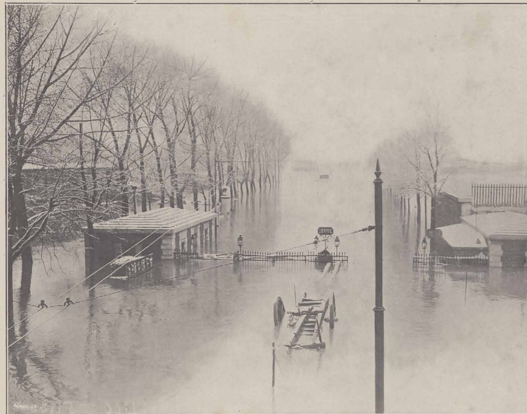
PORTE DE LA GARE (quai de la Gare).
