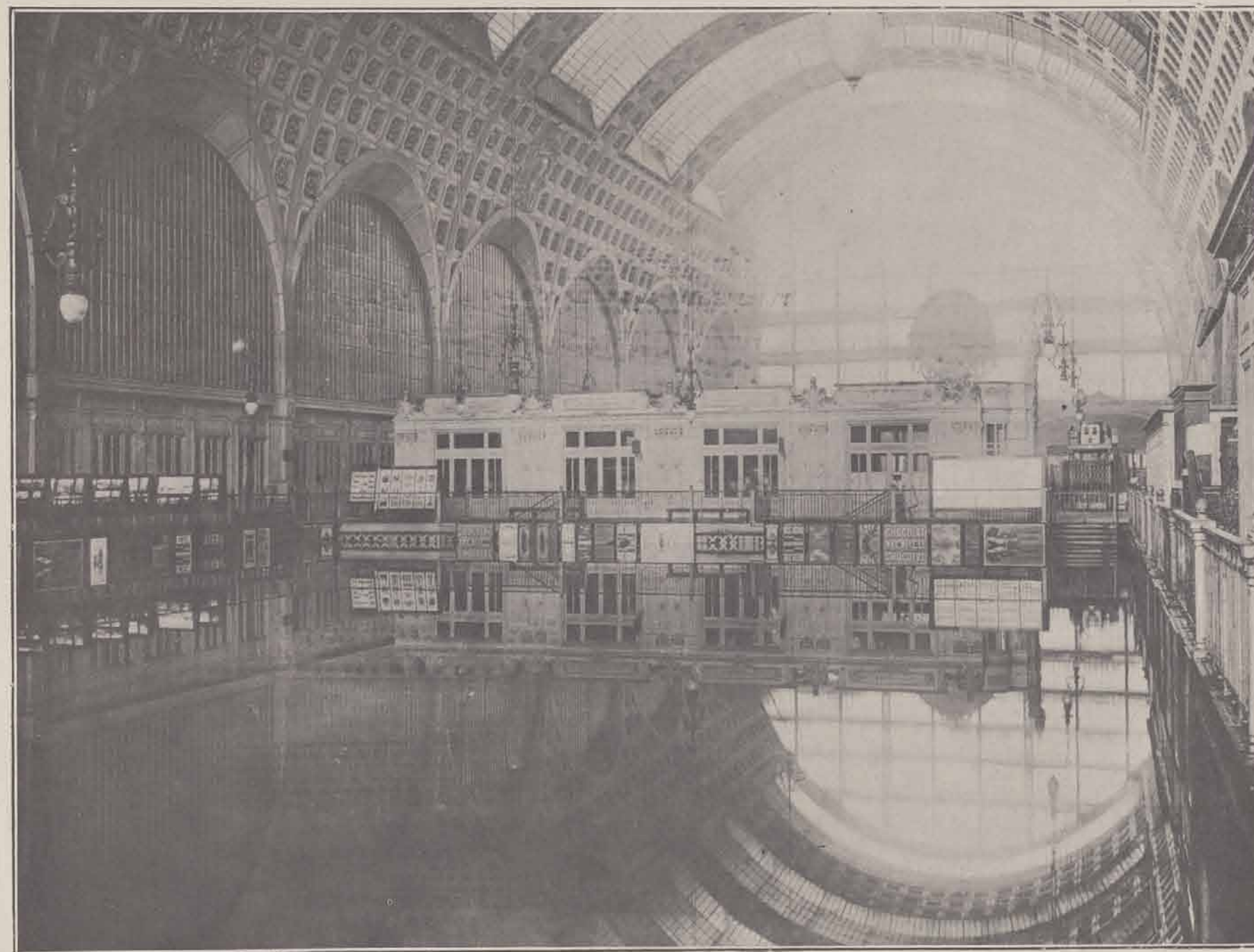
INTÉRIEUR DE LA GARE DU QUAI D'ORSAY
