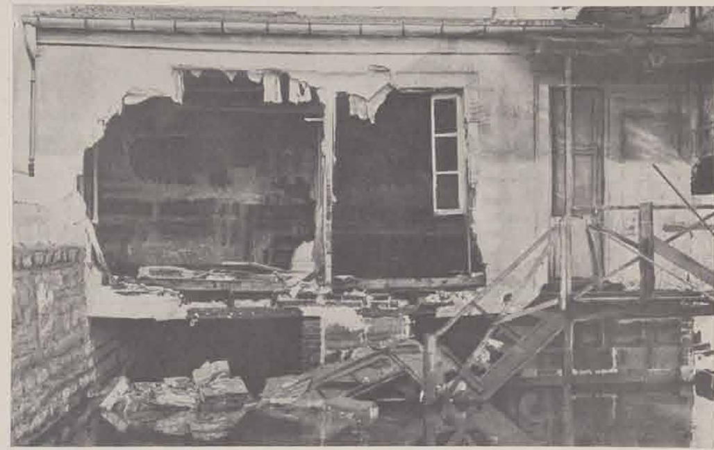
GENNEVILLIERS. — Maison éventrée par les eaux.
