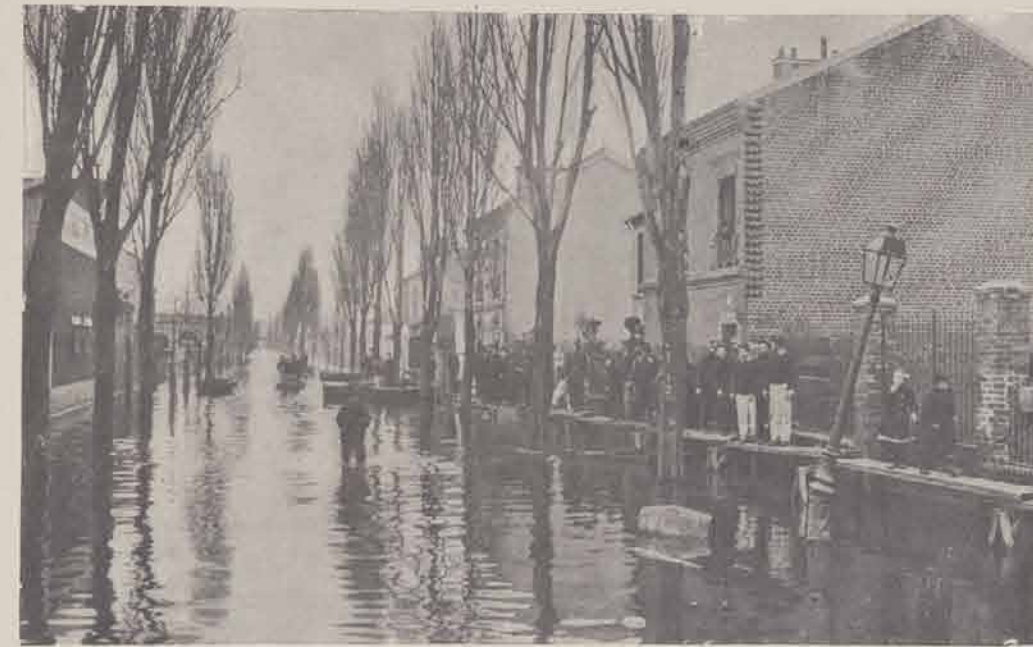
ISSY. — Boulevard du Point-du-Jour.
