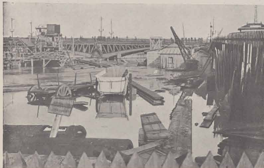
Travaux du métro au pont Mirabeau.
