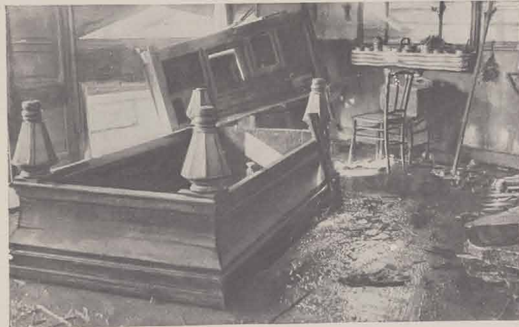
GENNEVILLIERS. — Intérieur d'un débit de vins après l'inondation.
