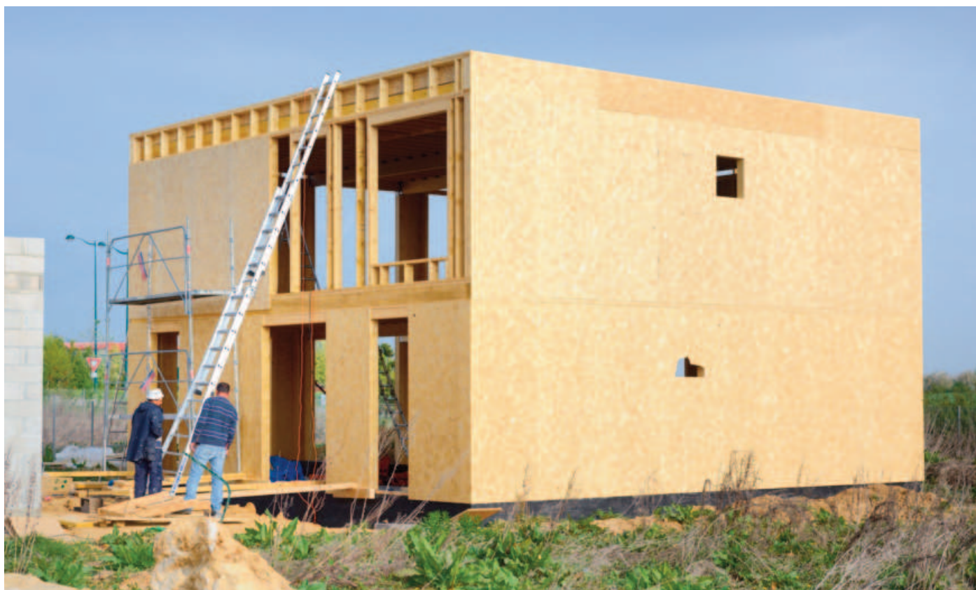
Maison à ossature en bois à Chessy (Seine-et-Marne)
