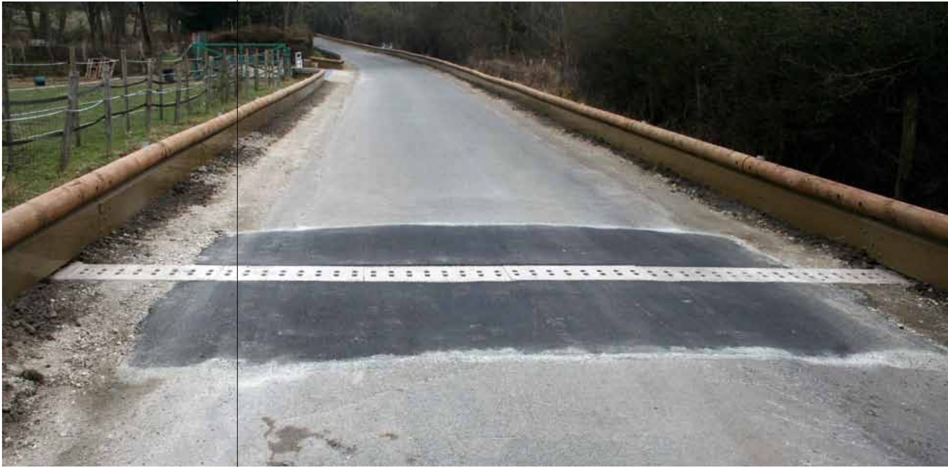
Le crapauduc de Condé-sur-Vesgre. Les barrières empêchent les crapauds de traverser la route et les guident vers des passages souterrains (ici, percés de trous) leur permettant de rallier leur mare de reproduction sans se faire écraser. © D. Robert/Atena 78
