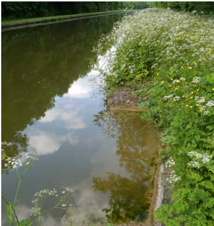
Les grandes rivières constituent des obstacles naturels pour une partie de la faune. Certains animaux sont cependant capables de les traverser à la nage. L'enrochement des berges peut néanmoins transformer la traversée en véritable piège, en particulier sur les canaux. Il est alors nécessaire de mettre en place des dispositifs anti noyade tel qu'ici, sur le Canal du Loing à Sorques. Une entaille en plans inclinés dans la berge est suffisante et dure beaucoup plus longtemps que les dispositifs métalliques existants. © V. Vignon
