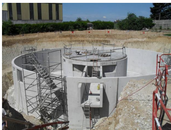
Bassin de rétention en béton armé
