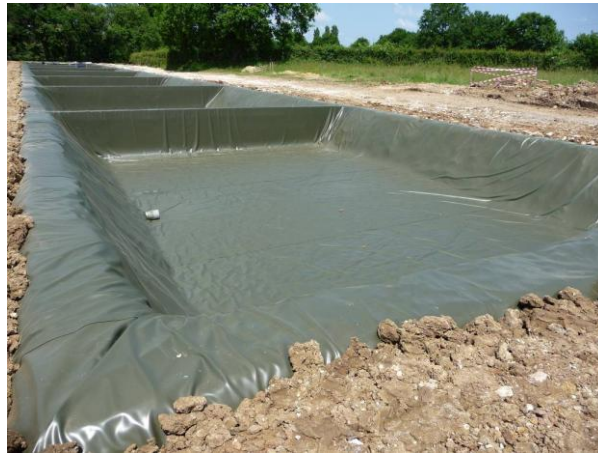
Bassin de rétention avec étanchéité par géomembrane
