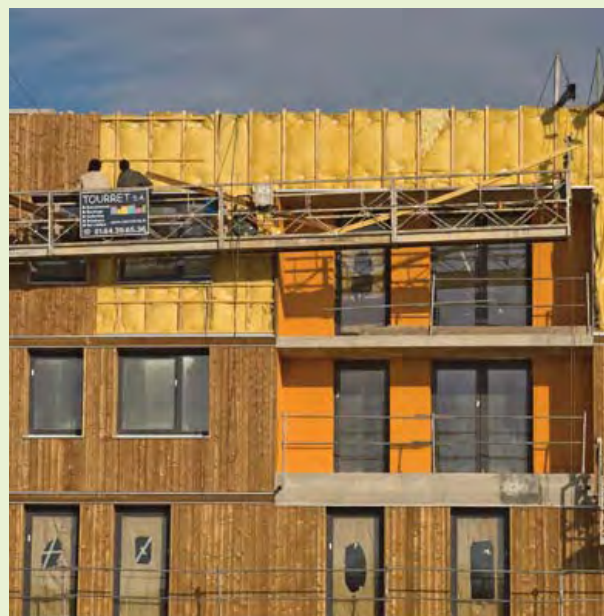
Construction de logements à Clichy sous Bois, isolation extérieure - DREIF / Gauthier
