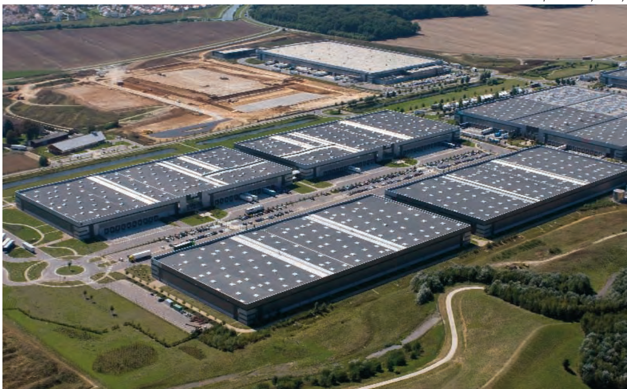
Entrepôts à Moissy Cramayel
