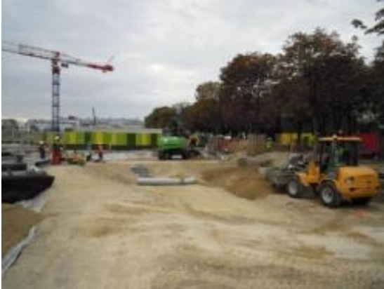
chantier des halles à Paris
