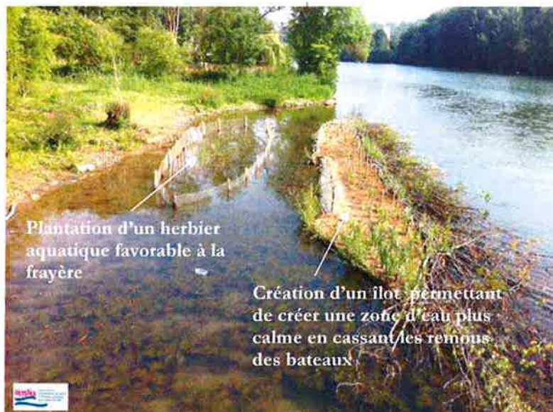
Travaux de création d'une frayère à poissons réalisés par le SMSO en 2011
