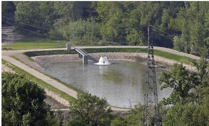
Figure 64 : Photographie d'un bassin de ré-infiltration en nappe (Grand Lyon – protection du champ captant de Crépieux-Charmy) 13
