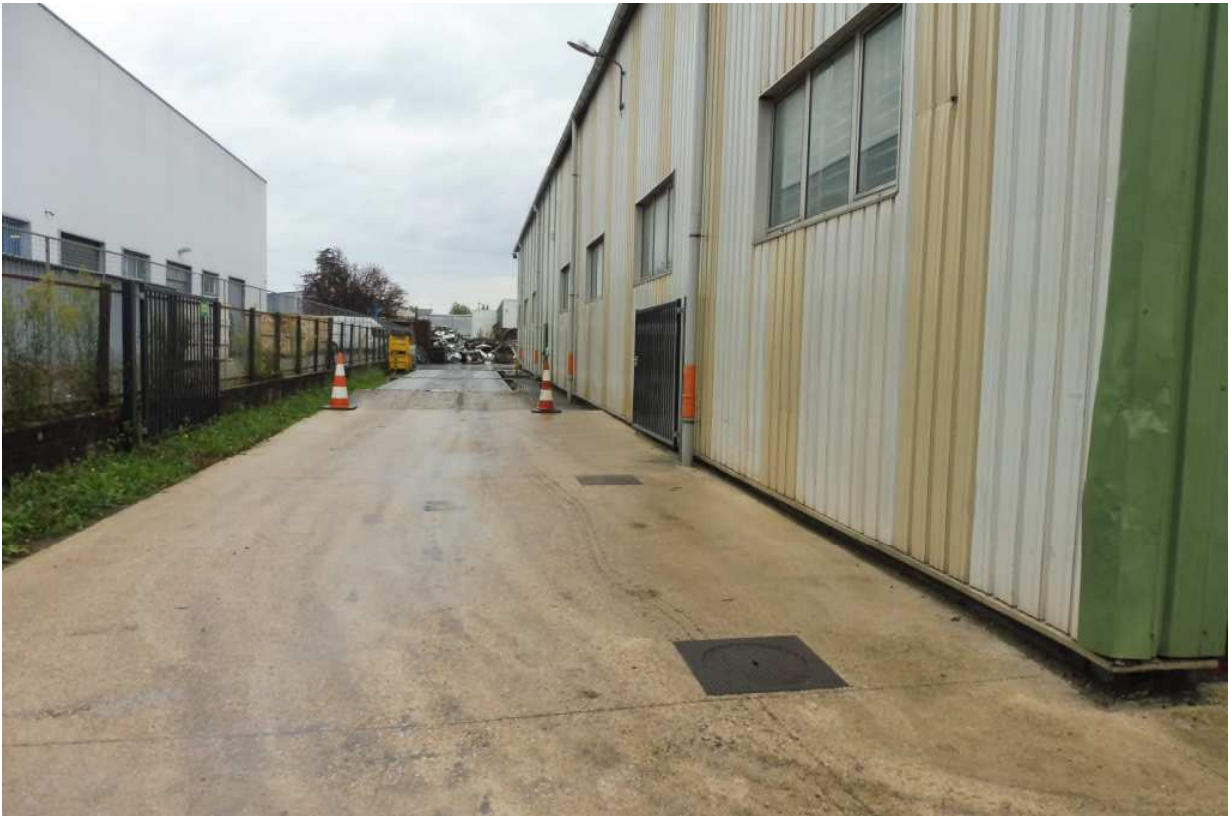
Voie d'accès et pont bascule
