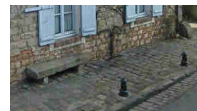
Ensemble d'éléments mobiliers anciens à préserver (bancs de grès, chasse-roue, bordure et pavage du trottoir, plantation en pied de façade, etc.) au droit de l'Auberge Ganne.
