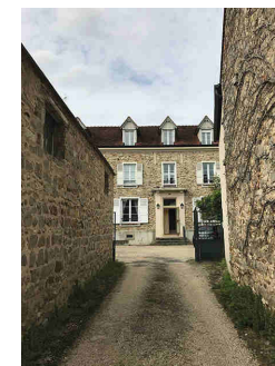
Bâti de second rang et venelle d'accès à la cour intérieure
