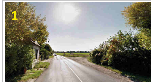
1. Entrée nord-ouest, par la RD64
