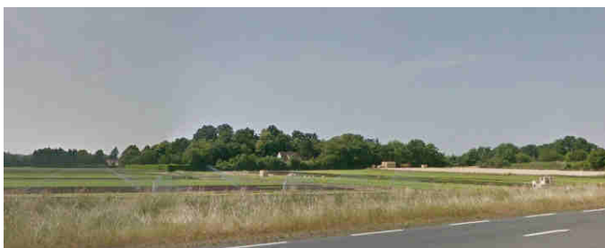
Boisement des parcs et jardins masquant les constructions récentes depuis la RD637
