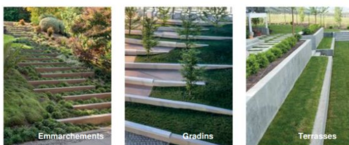
Illustration 11 : Différentes manières de gérer la pente avec de gauche. Source : CPAUPE
