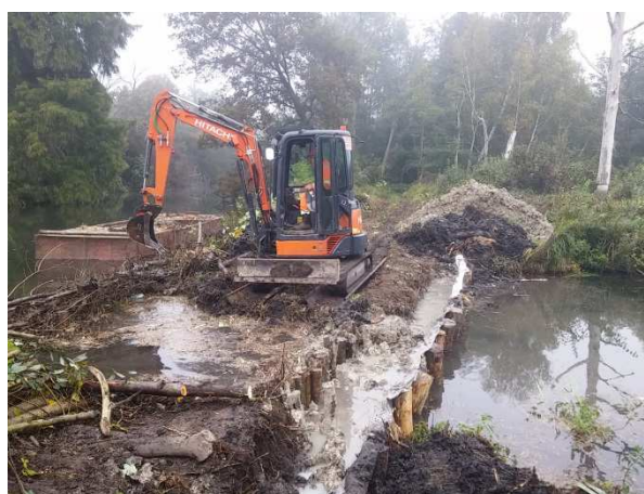
Traitement de brèches en berge
