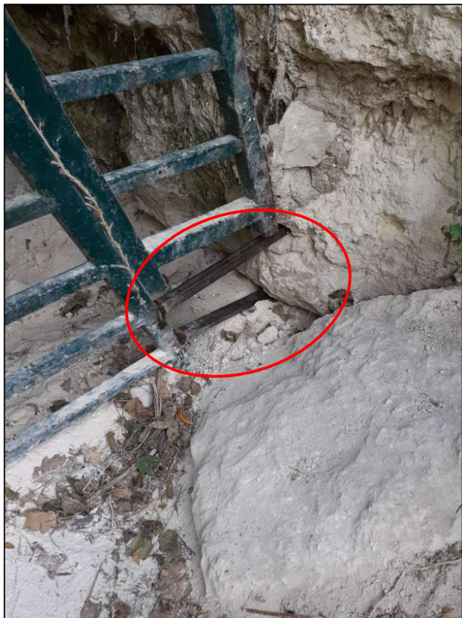
Ajout de barreaux anti-intrusion
