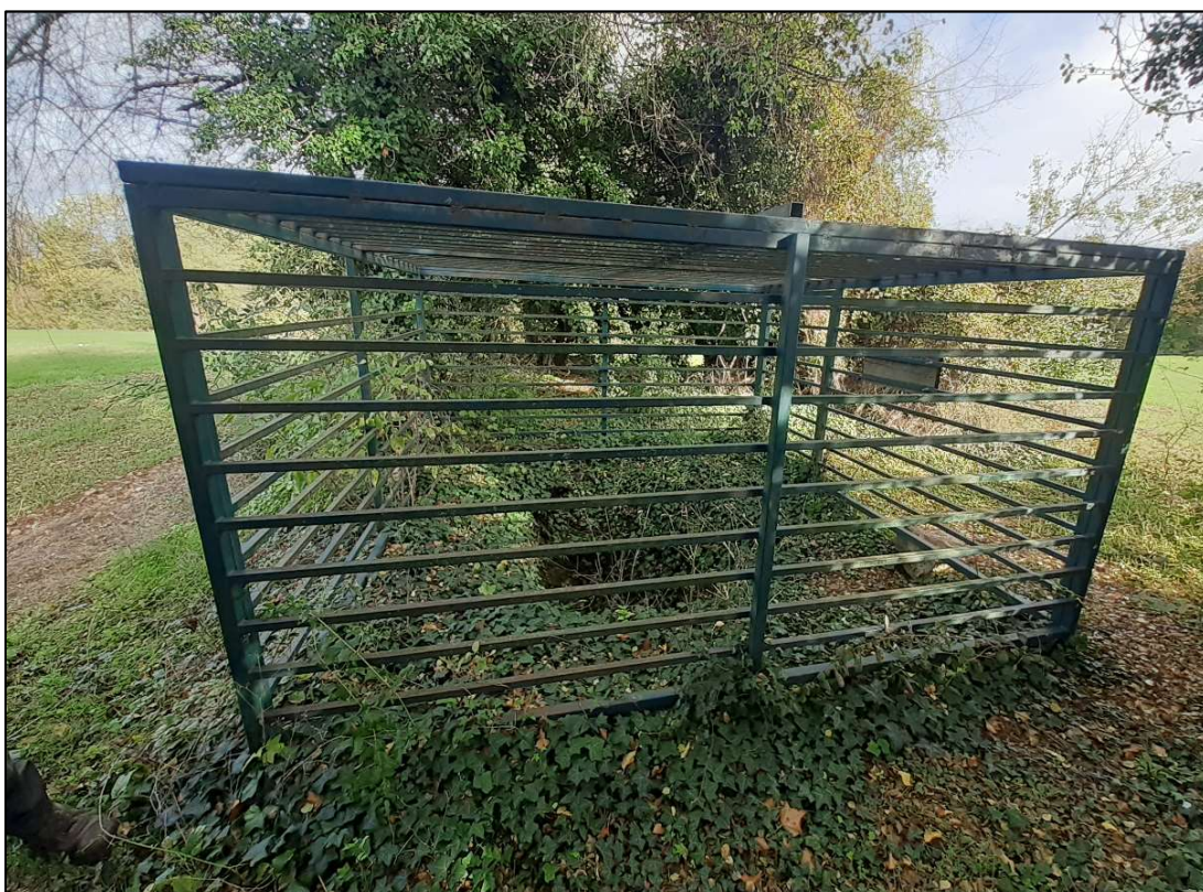
Sortie du puits dans la plaine agricole
