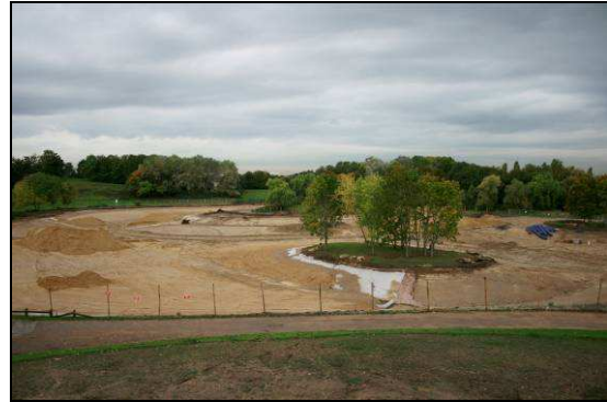
Mise en place de l'îlot central © CG93
