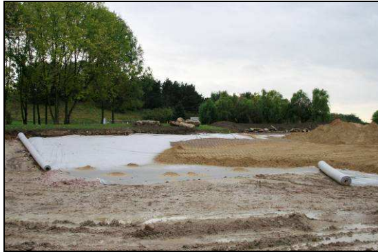
Pose de bâches étanches © CG93
