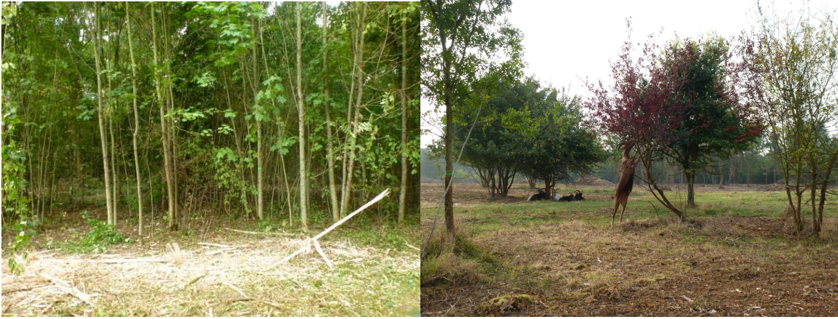
Premier jour des travaux
