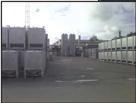
Vue sur le stockage des conteneurs vides et les tours à charbon actif
