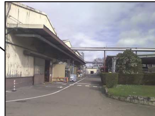
Vue sur le bâtiment de production et l'auvent de stockage
