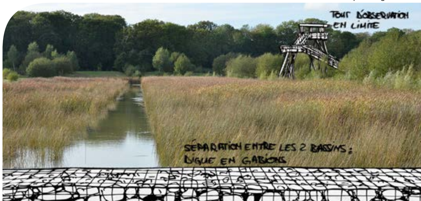
Vue sur la ZNIEFF depuis la digue centrale
