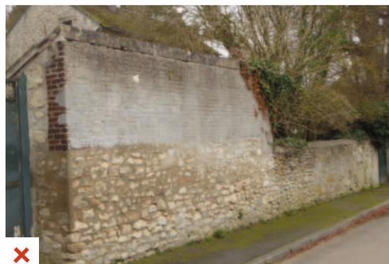
Rénovation d'un mur en pierres avec un mortier en ciment peu qualitatif et surmonté d'un mur de briques enduit au ciment
