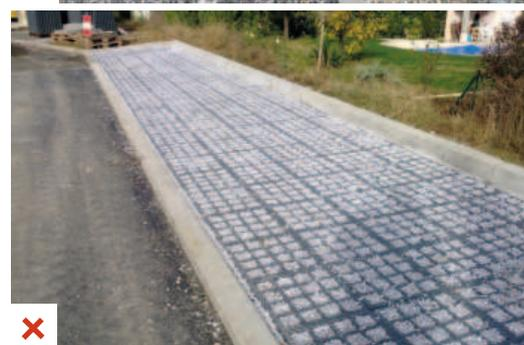
1. En-tête. stationnement en pavage granit, noue plantée et butte-roie pierre assurant le bon écoulement des eaux de ruissellement.
