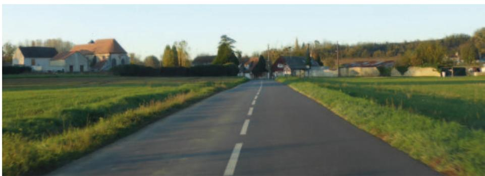
*Absence de fossé à droite et rigole béton à gauche, les deux apportant peu de qualité et d'infiltration aux paysages agricoles.*
