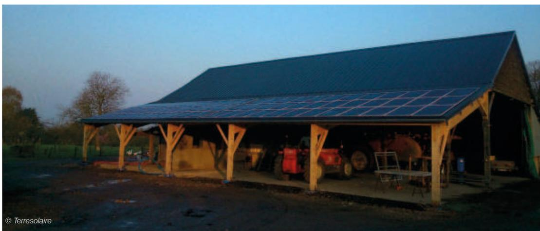
Boisset-les-prévanches, 27 - Bâtiment agricole équipé de panneaux photovoltaïques en toiture. Les panneaux sont situés sur un appentis, ce qui permet de laisser très lisibles la structure principale et le volume du bâtiment.
