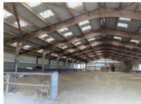
*Les usages des bâtiments agricoles et équestres nécessitent des bâtiments de grande portée. Les structures peuvent être en bois massif, bois lamellé collé ou en métal*
