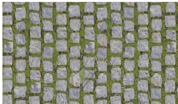
1. En-tête / zone de stationnement réalisée en pavés béton préfabriqués en espace urbain. Les joints sont enherbés sur les zones piétonnes, tandis que les espaces circulés sont en sable. La voirie, plus sollicitée, est en enrobé.
