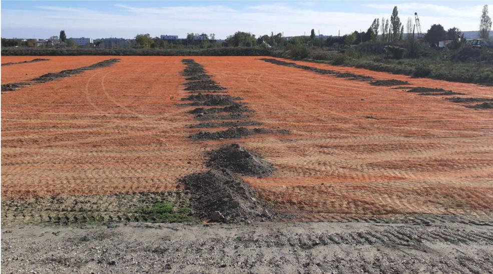
*Pose du grillage avertisseur sur la couche d'argile et avant mise en place de la couche finale*
