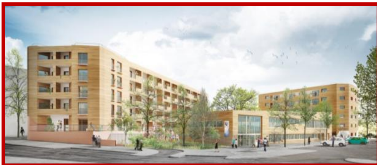
Bâtiment passif à Savigny le Temple, logements sociaux locatifs et accession (PSLA) et bureaux de Pôle Emploi. (COOPIMO- architecte F.H. Jourda)
