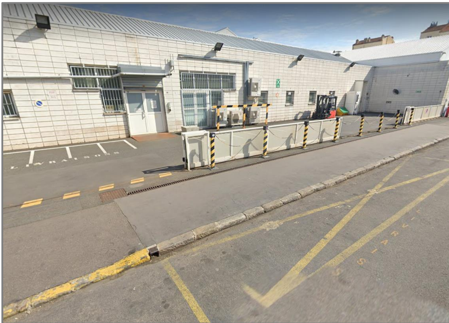
Vue du bâtiment depuis la rue Beurepaire : zone de chargement-déchargement des camions
