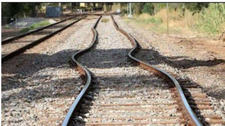
Figure 5 : Gros défaut de nivellement - Source :[Ensemble sur les lignes N et U](#)
