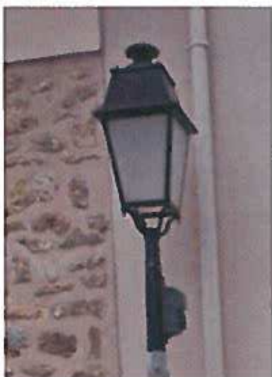
Lanternes actuelles : ampoules aux vapeurs de mercure et vitrages opaques, lampes pendantes
