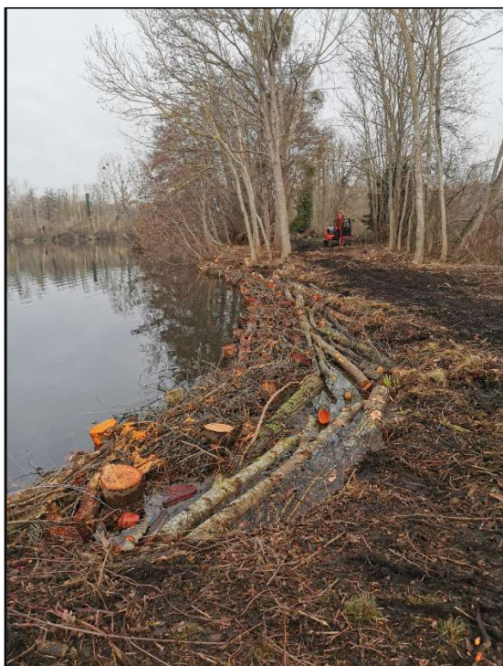
Installation de pieux-fagots pour limiter l'érosion de la berge
