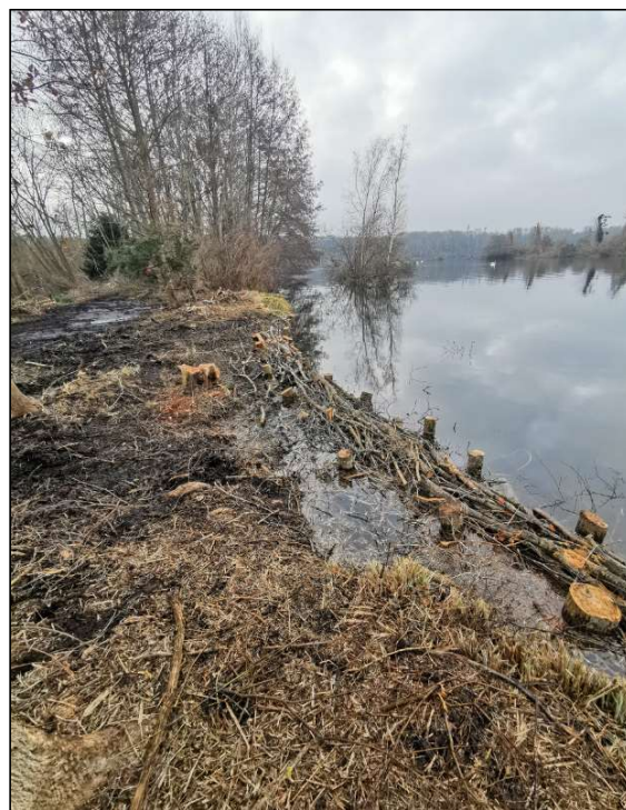
Installation de pieux-fagots pour limiter l'érosion de la berge
