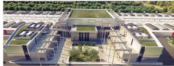
Au centre de l'implantation des ouvrages, la zone de relevage est marquée par le rythme des portiques de maintenance des pompes.
