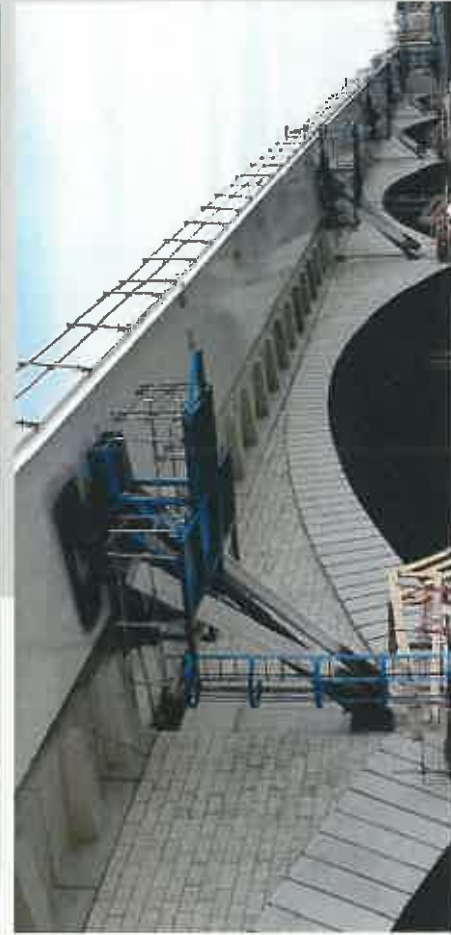
Élargissement du pont National
