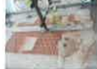
Détail d'un des panneaux de façade recouvert d'un enduit fausse brique, également utilisé pour le château de Versailles. C'est un témoignage intéressant de la persistance de ce décor en plein règne de Louis XV.
