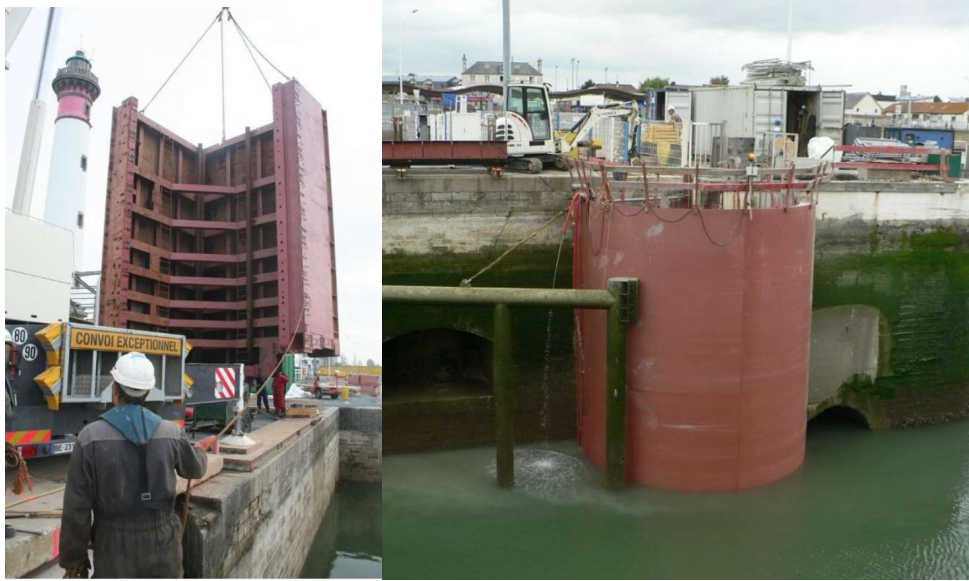
Figure 9 : Batardeau ventouse (Source Port de Ouistreham, la Verchénne)
