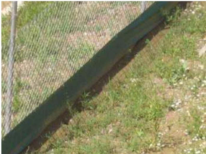
Exemple de barrière en géomembrane associée à une clôture
