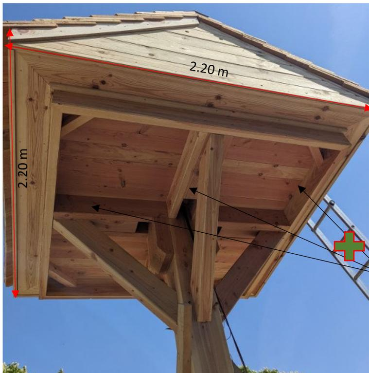
Il s'agit de partir sur la même base de structure illustrée ci-contre pour l'H. de fenêtre mais d'y ajouter pour l'H. rustique un soubassement en bardage bois qui descend sur 1,3 m de hauteur pour que les nids soient plus confinés.
