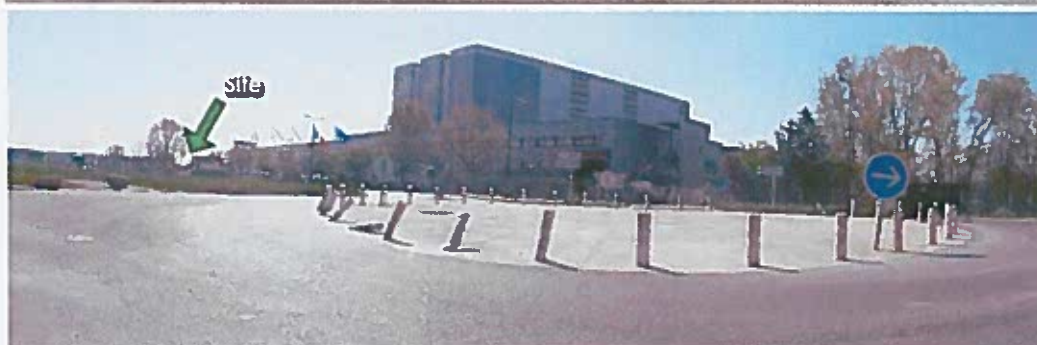
Voies d'accès au site
