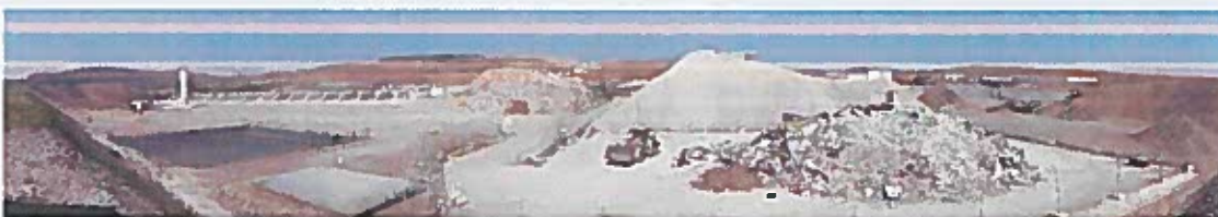
Zone plateforme traitement des DAE de chantiers
