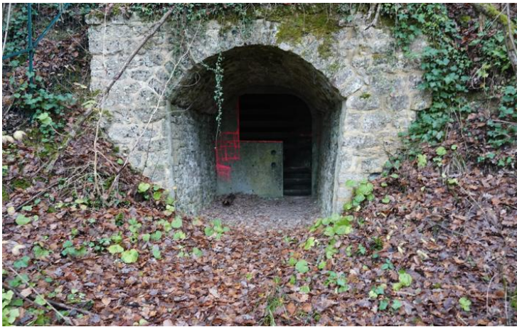
Une des entrées de la carrière de Mocpoix
