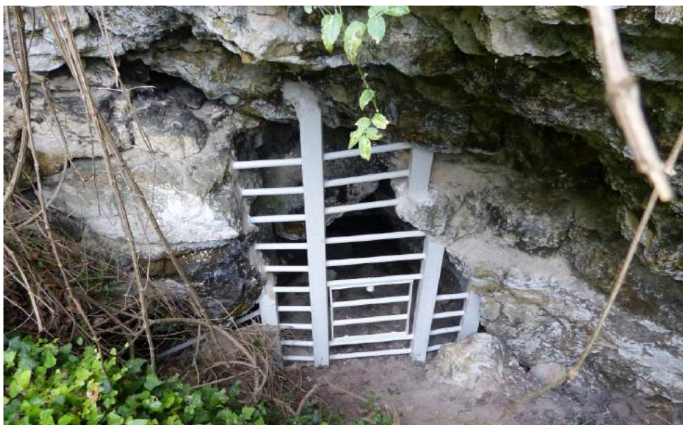
Figure 5 : Aménagement de fermeture de cavité à Vétheuil par un contrat Natura 2000 en 2012
