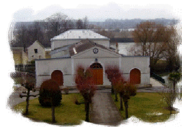
L'usine élévatoire de Trilbardou, © Lundoux
