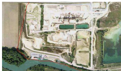
Installations (stockage, tri...) de Précy-sur-Marne © Interatlas 2005
