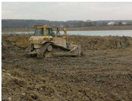
Carrières de Congis-sur-Thérouanne lors des travaux d'aménagement © M. Pajard
