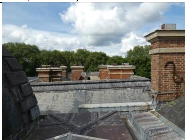
Toit du château
