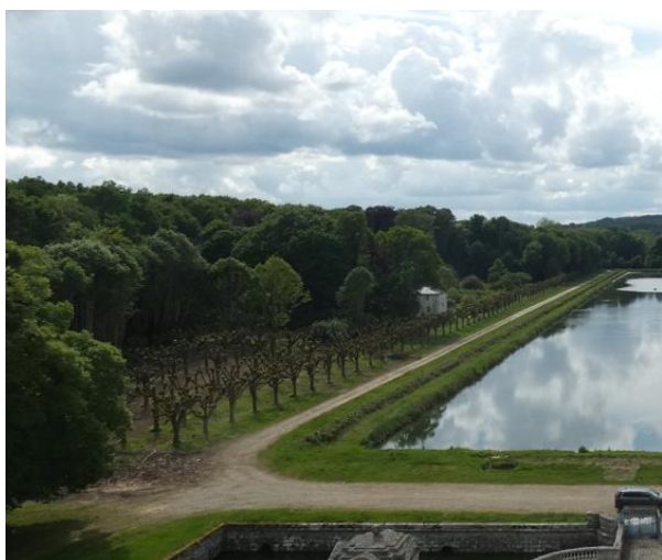
Vue sur le Pavillon du Lac depuis le toit du château
