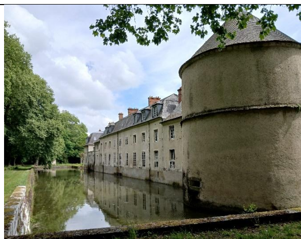
Façade nord des Communs et le douves
