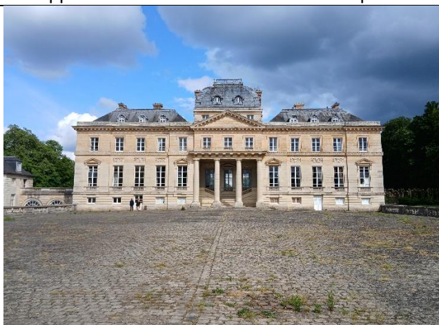
Façade ouest du château
