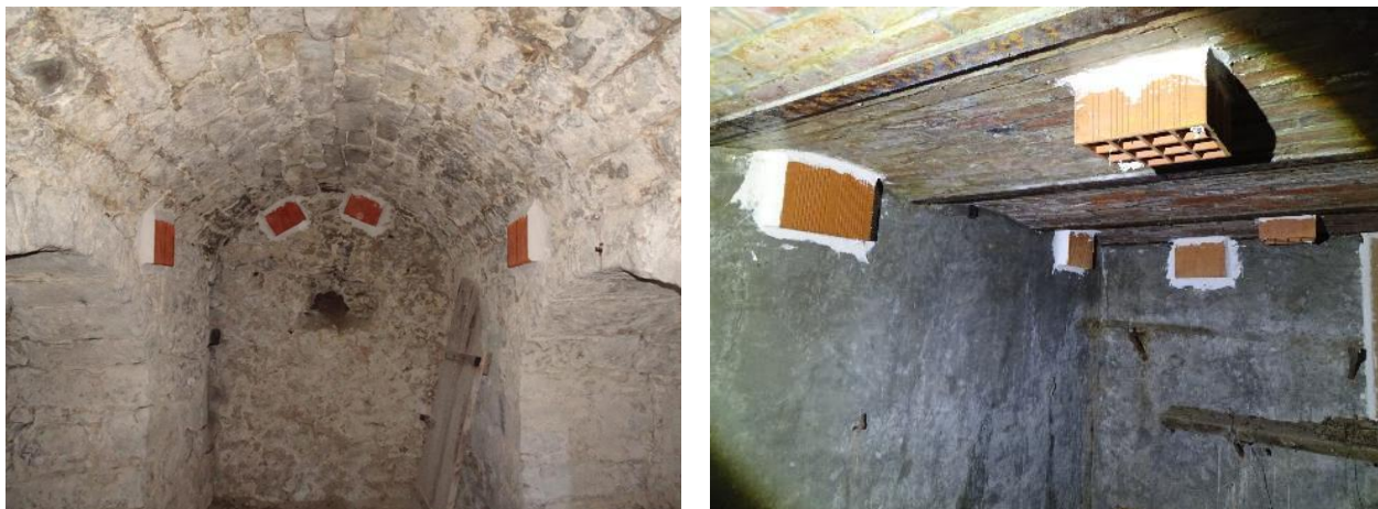
Figure 3. Exemples d'aménagements : Mise en place des briques creuses favorisant l'installation des Chauves-souris (©Ecosphère)
