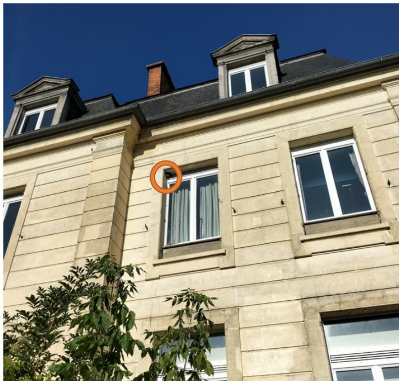
Photographies de 4 des 7 nids sur les deux bâtiments annexes au projet.
