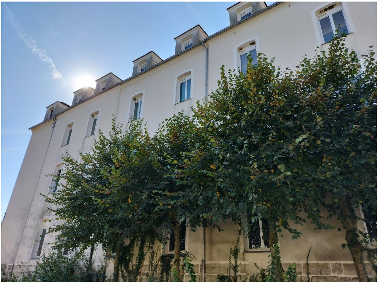
Photographie de la face Nord du bâtiment Montesquieu, principal habitat des hirondelles sur le site de Juilly.
