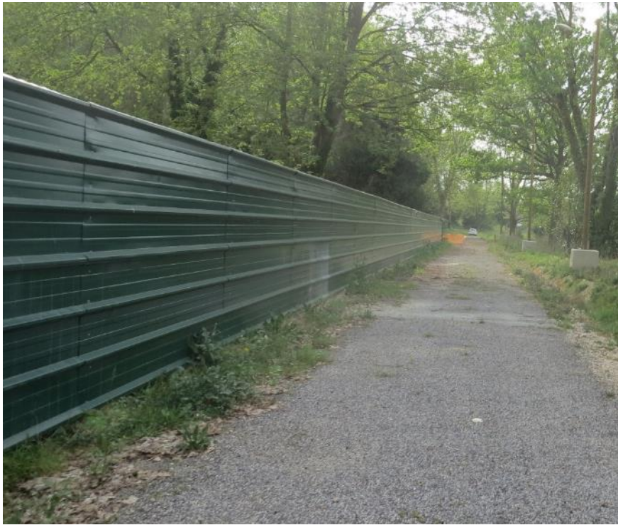
Figure 25 : tôle bardée autour des lots en chantier
