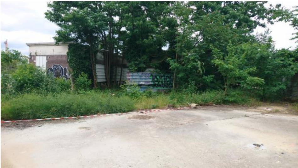
Figure 13 : Friches arbustives autour d’un bâtiment abandonné
