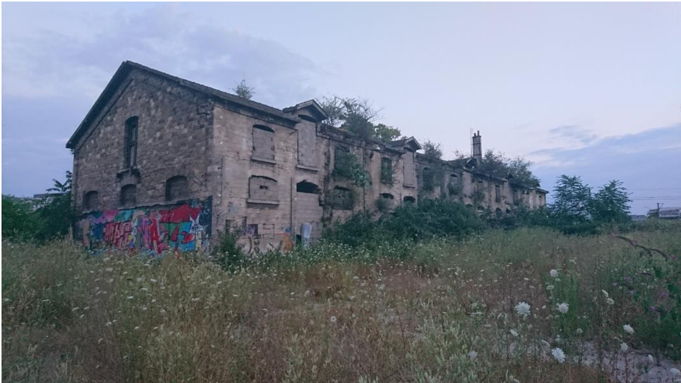
Figure 29 : bâtiment et friches périphériques directement impactées
