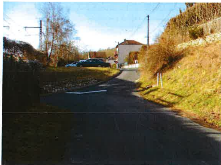
Point bas du tunnel SNCF
