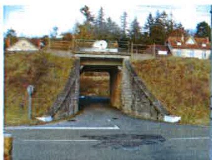
Tunnel sous la voie ferrée
